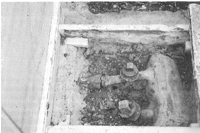
Fot. 32: Acometida de aguas en la casa de Vesconio Primo en Pompeya VI, 14, 20. Bajo una losa de mármol junto al impluvio, se guardaba todo un privilegio: el registro de enlace de la casa con el ramal de la conducción pública de aguas.
