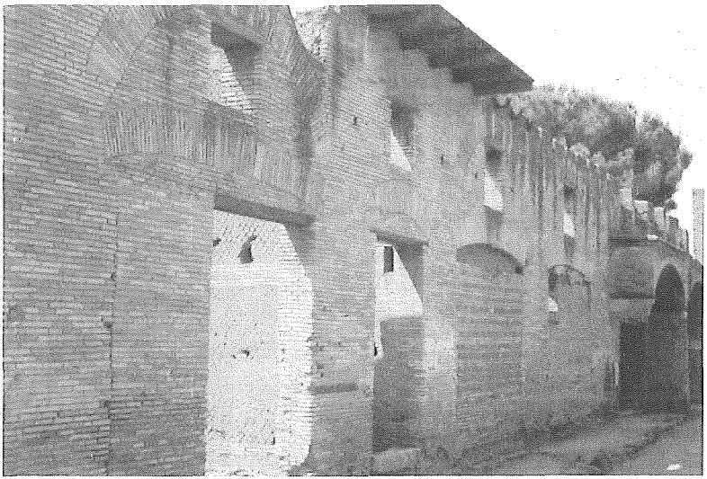
Fot. 30: Vista de la calle de Diana en Ostia, con las fachadas de los inmuebles del Termopolio y del Balcón. En primer término, sobre el entresuelo, un balcón de madera. Al fondo, y sobre una puerta, nacen bóvedas sobre ménsulas de piedra que permiten crear otro tipo de balcón.
