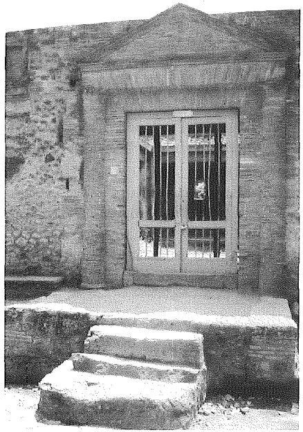
Fot. 7: Vestíbulo de la casa de Julia Félix en Pompeya II, 4. La majestuosidad se consigue mediante la escalera que avanza hacia la calzada, el alto vestíbulo sobre podio y el frontón que remata la puerta. Posee además un banco de piedra en el lado izquierdo.
