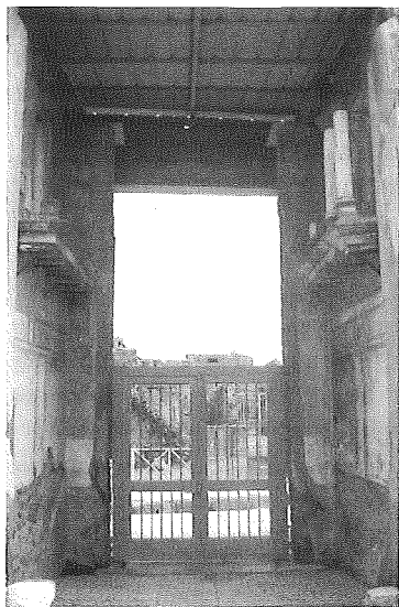
Fot. 11: Fauces de la casa del Fauno en Pompeya VI, 12 (véase fot. 4 y 15). Pasillo alto y estrecho seccionado por la puerta y decorado con pinturas murales y una repisa a modo de podio sobre la que se elevaban pequeñas columnas, quizá de una cubierta falsa no conservada.
