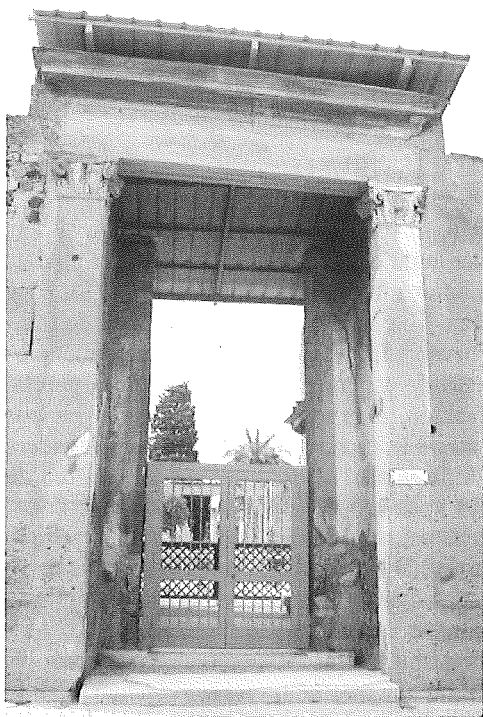
Fot. 4: Vestíbulo de la casa del Fauno de Pompeya VI, 12: la puerta se desplaza hacia el interior dejando un espacio delante, a modo de portal hasta la calle. A destacar las pilastras con capiteles, el entablamento y las dimensiones del rano.
