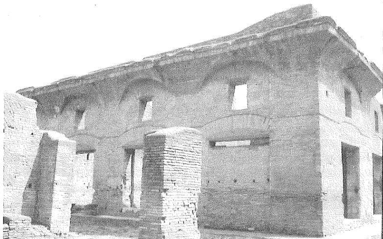
Fot. 31: Vista de la casa de Diana en Ostia I. 3, 3-4. Sobre el entresuelo unas seu-dobóvedas forman lunetos en las ventanas y, levantadas sin ménsulas, soportan la plataforma a modo de gran cornisa que corre a lo largo de las fachadas.
