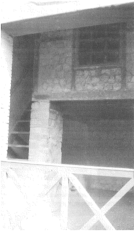
Fot. 58. Bodega de la Prensa de Madera en Herculano III, 12. Posee una pergula ganada en el espacio de un altillo y encubierta dentro del edificio. El acceso se lograba mediante escalera lateral. Iluminación indirecta a través de la ventana abierta hacia la puerta del local. Altura reducida.
