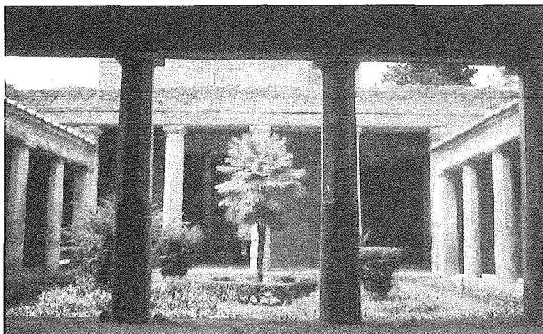
Fot. 25: Peristilo rodio de la casa de las Bodas de Plata en Pompeya V, 2, i. Se caracteriza por la peculiaridad formal de presentar un pórtico más elevado.
