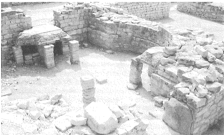
Fot. 36: Termas de la casa del Delfín en Vaison la Romaine. Se observa el sistema de hypocaustum bajo el caldarium absidado. El doble suelo elevado continuaba en la habitación siguiente, el tepidarium.
